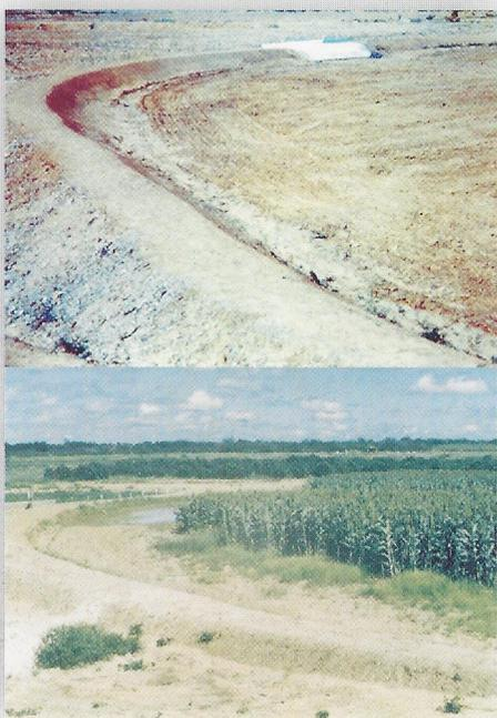
Um a alternativa tecnológica de captação e armazenamento de água de chuva que contribui com a redução dos efeitos negativos dos períodos de estiagem é a **Barragem Subterrânea**
