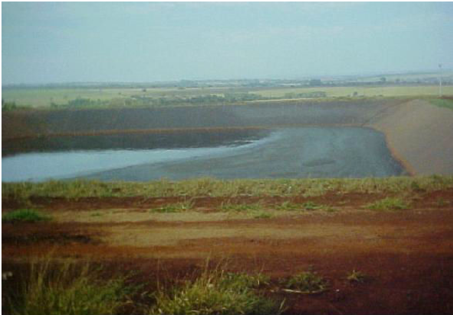
sistema tradicional de manejo de dejetos utilizando lagoas de estabilização
