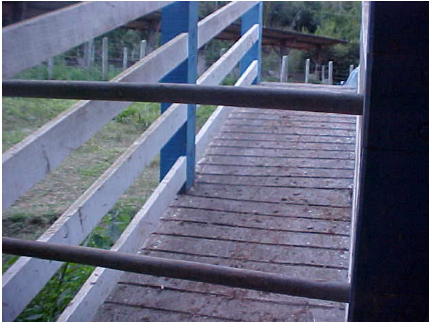
Detalhes do piso do embarcadouro (a), e porteira de acesso ao curral de manobra (b)
