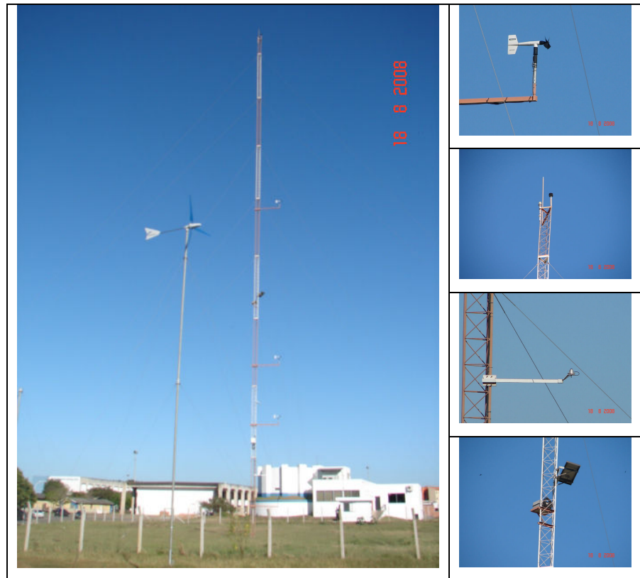
Figura 2: Torre anemométrica e solarimétrica instalada no Parque de Energia Alternativa – PEA/UENF
